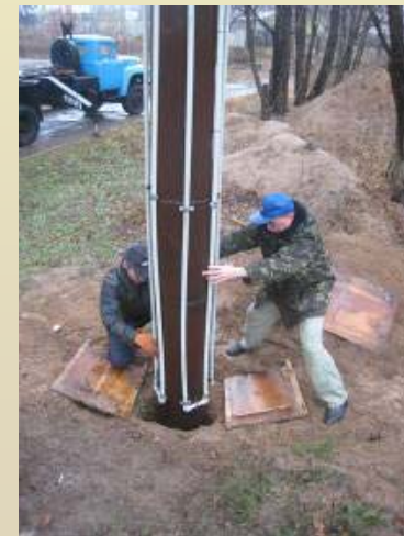
Вилучення відновлюваної теплоти ґрунту за допомогою бетонної палі із теплообмінниками
