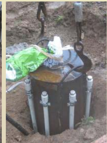
Вилучення відновлюваної теплоти ґрунту за допомогою бетонної палі із теплообмінниками
