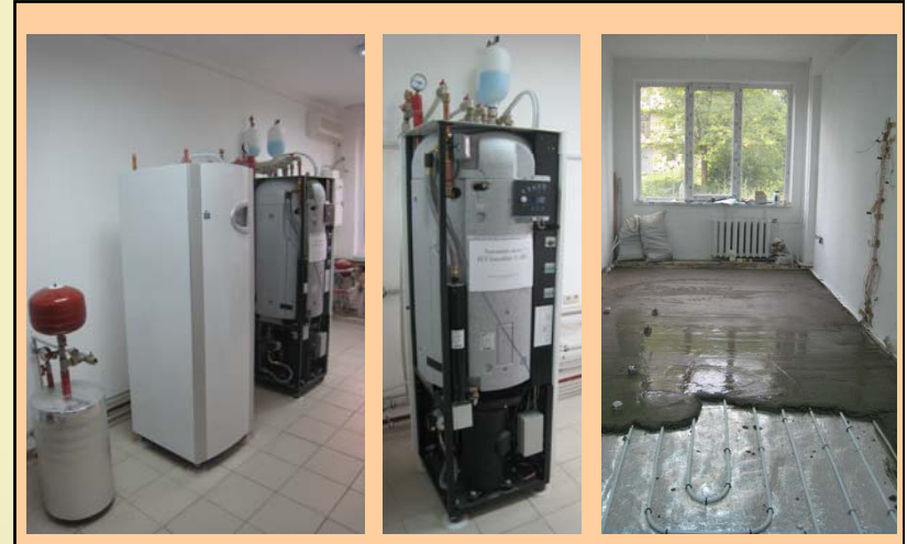
Теплові насоси “ґрунт-рідина” IVT Greenline 6 C та 11 C
