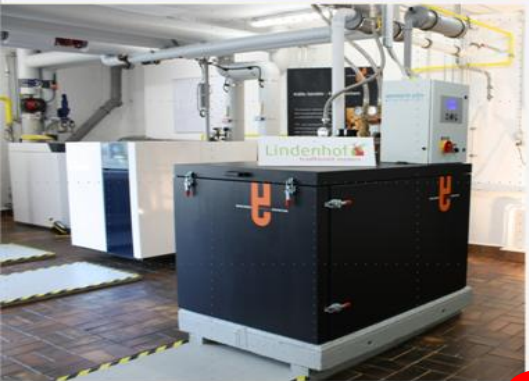
CHP Lindenhof 20 kW el / 46 kW th
